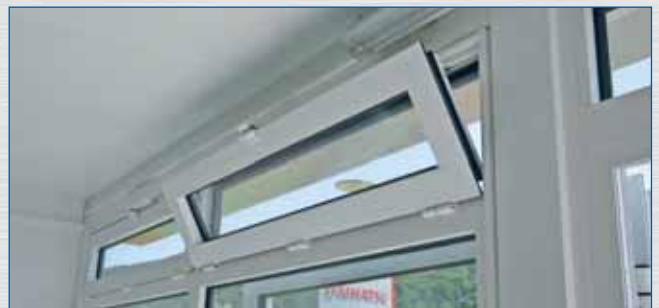
Yläikkuna – mahdollinen kippi-avausmekanismilla
