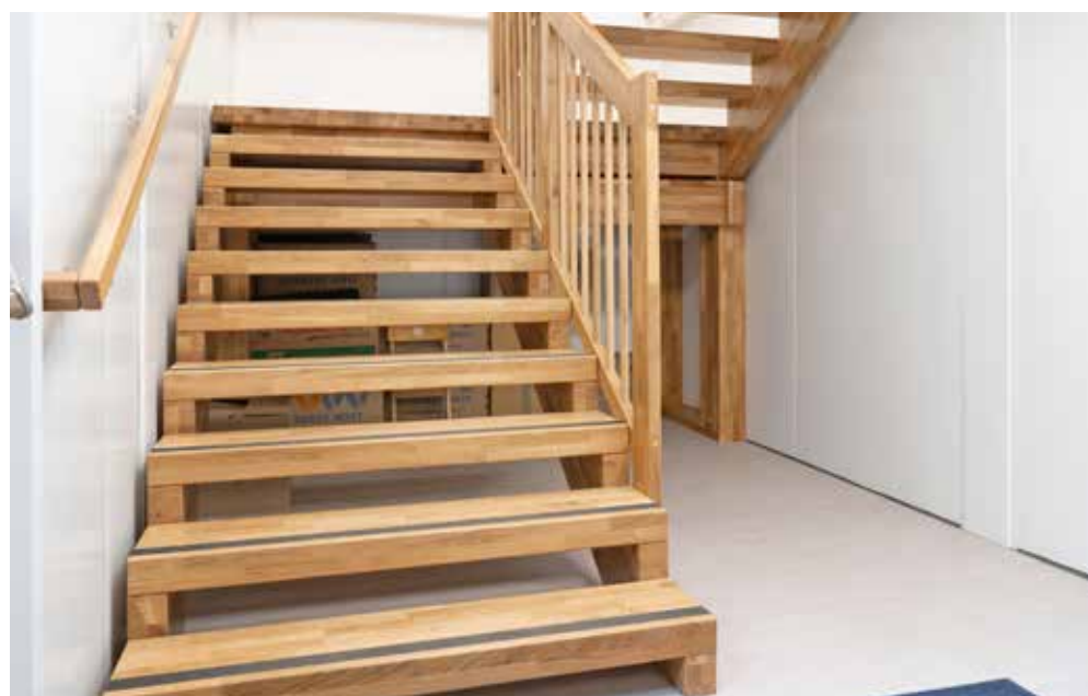
Escaliers intérieurs en bois massif de grande qualité
