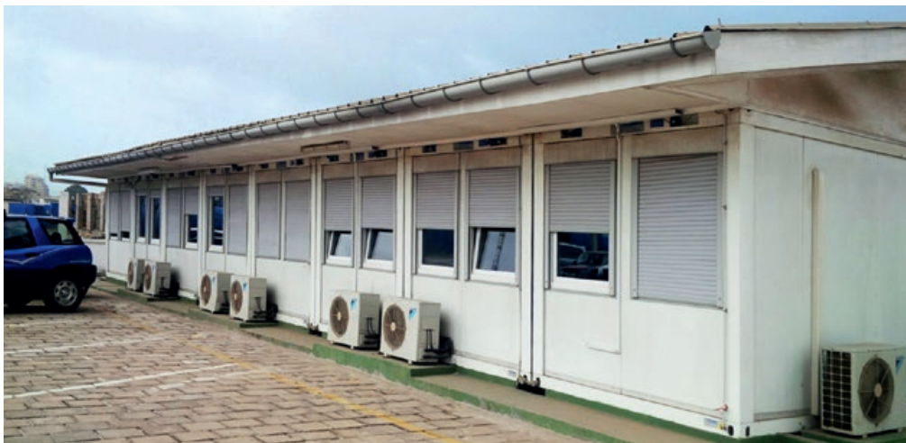
Bureau de chantier
