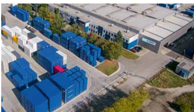
Stabilimento produttivo dei nostri container ad uso magazzino
