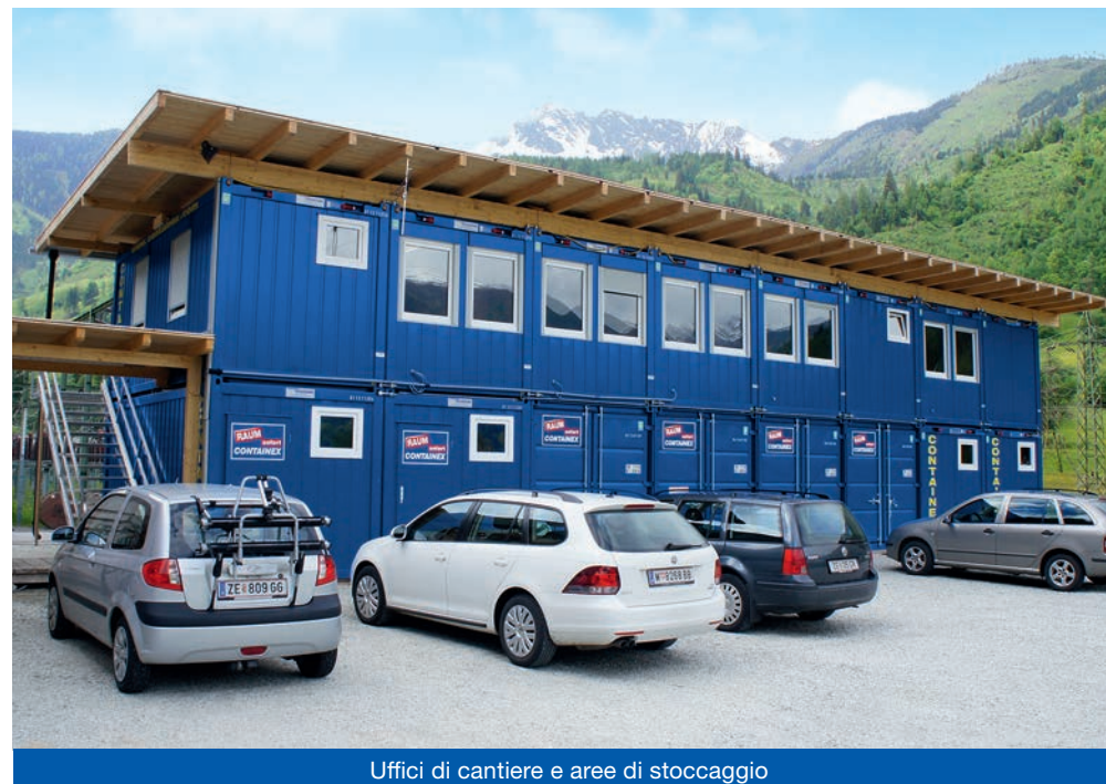
Uffici di cantiere e aree di stoccaggio
