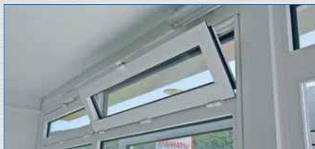
Świetliki – opcjonalne uruchamianie siłownika podnoszącego
