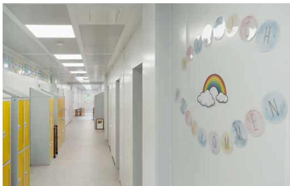
Zavesený strop a priebežná podlahová krytina
