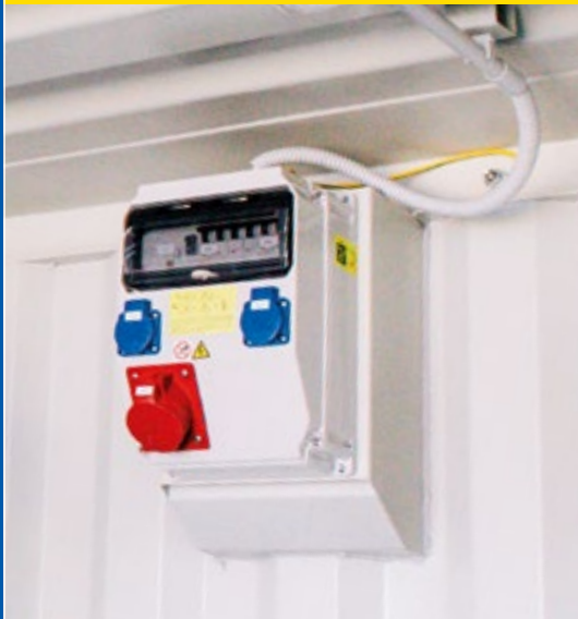
Електрическо табло с вграден предпазител
