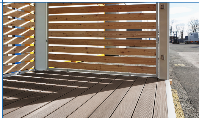
Drvena fasada od sibirskog ariša i pod od WPC dasaka
