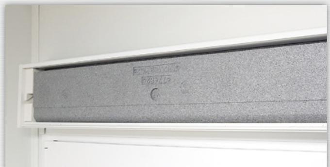
Rollladenkasten mit Dämmkeil
