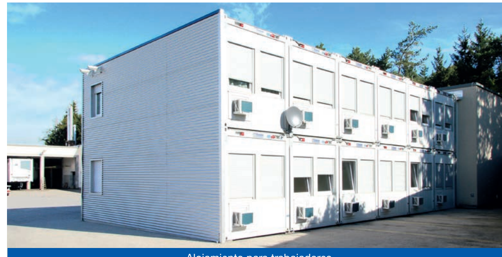
Alojamiento para trabajadores
