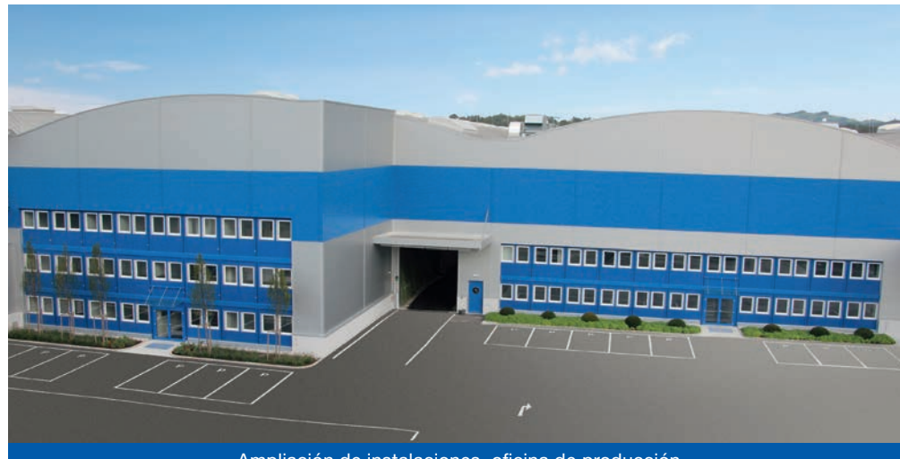
Ampliación de instalaciones, oficina de producción
