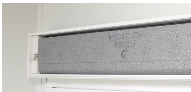
Szigetelőékkel ellátott redőnytok
