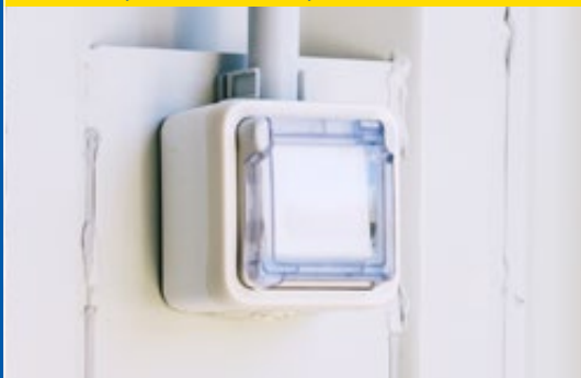
Salvavita con prese elettriche integrate
