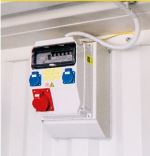
Verdelerkast met geïntegreerde wandcontactdozen
