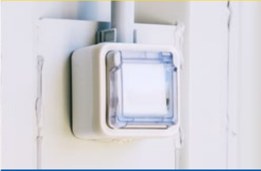
Verdelerkast met geïntegreerde wandcontactdozen
