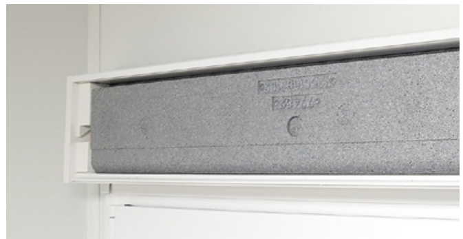
Sjalusikasse med ekstra isoleringskile
