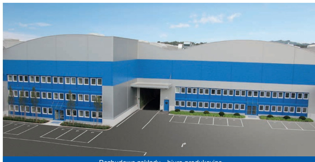
Rozbudowa zakładu - biuro produkcyjne
