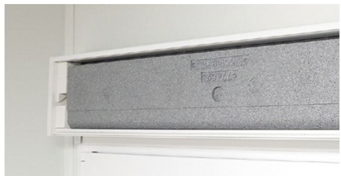
Casetă rului cu pană de izolare
