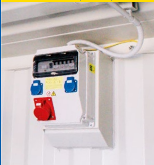
Panou electric cu prize încorporate
