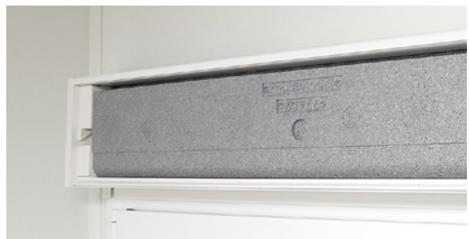
Короб для рольставней с изоляционной вставкой
