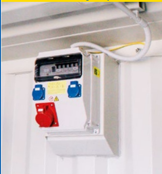
Rozvodná skrinka s integrovanými zásuvkami
