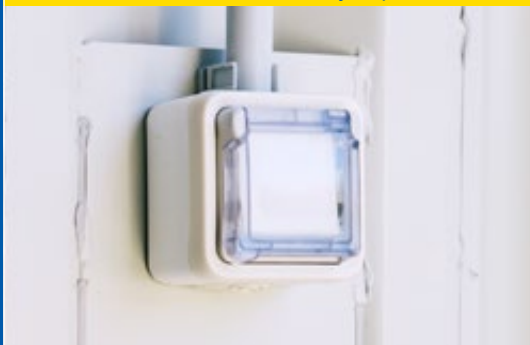
Rozvodná skrinka s integrovanými zásuvkami
