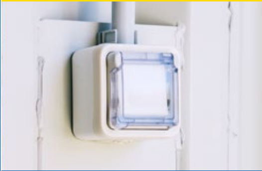
Razvodna kutija sa integrisanim utičnicama
