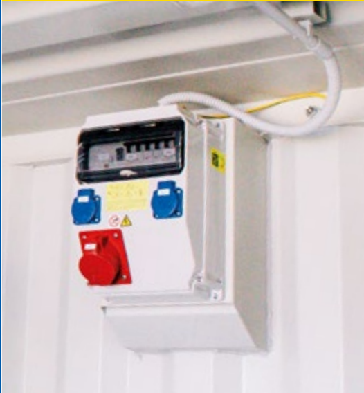
Razvodna kutija sa integrisanim utičnicama
