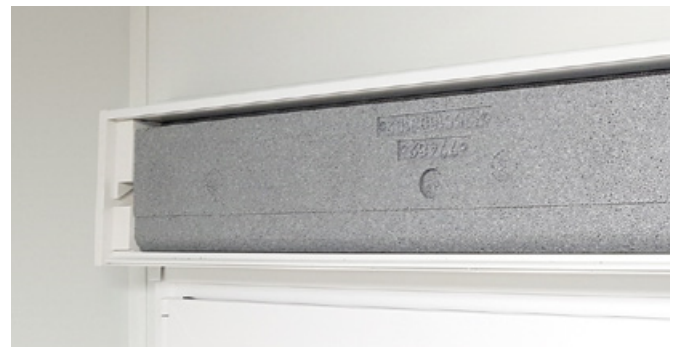
Jalusikassett med isoleringskil
